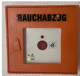
*Abbildung 11: Handmelder für Rauch- und Wärmeabzugsanlagen*
